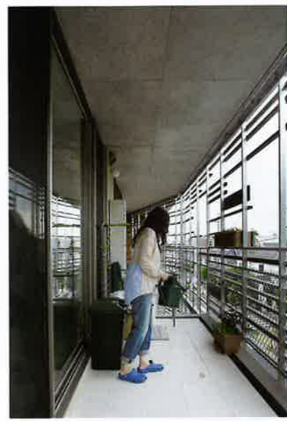
【写真3】バルコニーが生活空間に L住戸の西側バルコニー。木製ルーバーが外からの視線を遮ることで、バルコニーを部屋から延長する生活空間として生かせる。ベットのトリミングなど日常的に利用している
